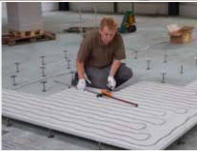
Der MERO Trockenhohlboden mit vorgefertigten Fräsungen für die Heizmittelleitungen wird nach Verlegeplan aufgebaut.
