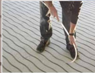
Das Kunststoffrohr wird einfach in die Halterillen eingelegt.
