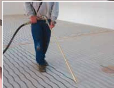
Vor dem Vergießen mit der Spachtelmasse werden die Leitungen auf Dichtigkeit geprüft.
