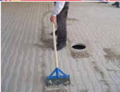
Die überstehende Spachtelmasse wird von den Trägerplatten abgeschoben.
