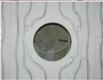
Ausschnitte sind vorgefertigt (beispielsweise bauseits einzubauende Elektrobodentanks)
